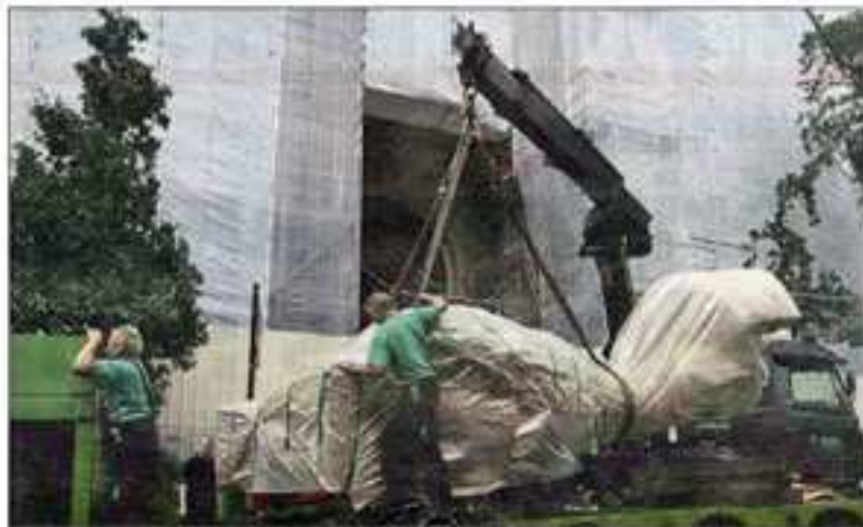
MUSEO DU GRAND PALAIS (VIII e ), HIER. Il a fallu se servir d'une grue et démolir une cloison pour faire entrer cette œuvre d'art de 5 m sur 5. (MUSEO 3366) © J. P. L. / A. M. / A. M.
