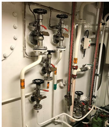
Système de Vannes à fermeture rapide ou Quick Closing Valve system
