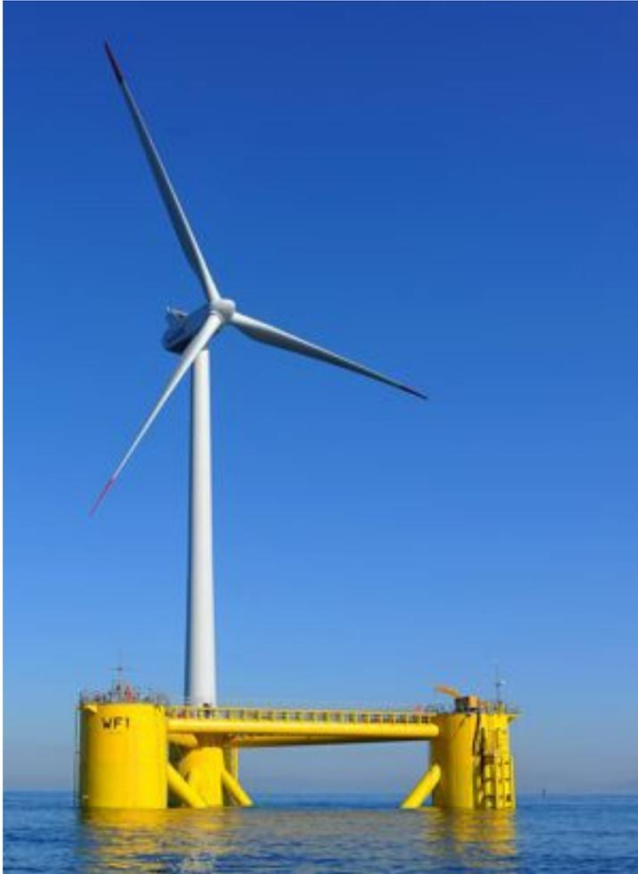
L'éolienne du projet « Windfloat » de l'électricien portugais EDP, repose sur l'un des coins de la barge triangulaire. D'un poids de 1200 tonnes d'acier et lestée par 1300 tonnes d'eau de mer, elle est capable de faire face à des creux de plus de 10 mètres. Ce prototype de 23 millions d'euros est raccordé depuis fin 2011 au réseau électrique portugais.
